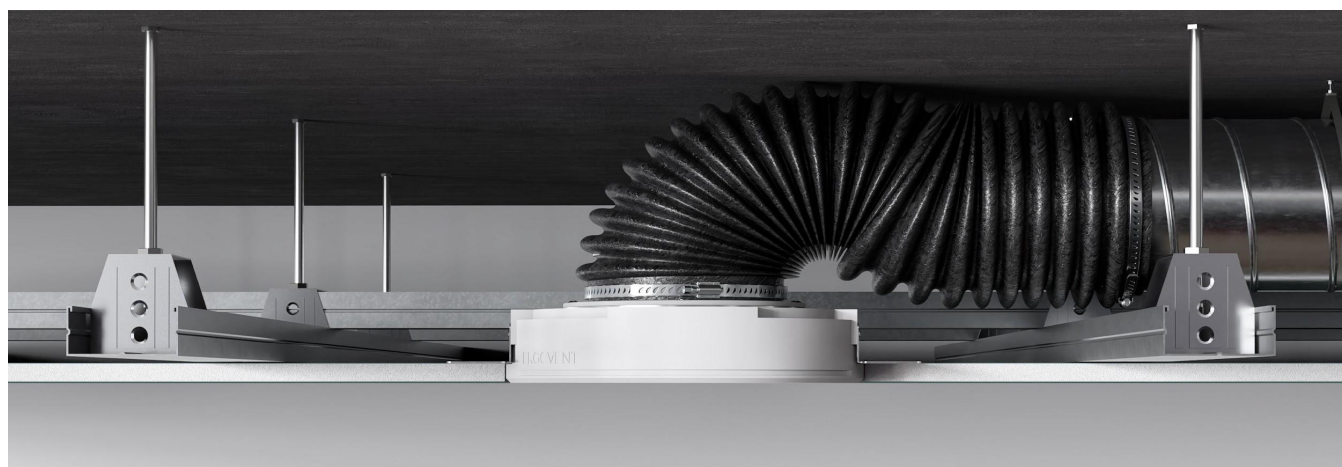
Монтаж с использованием гибкого воздуховода
