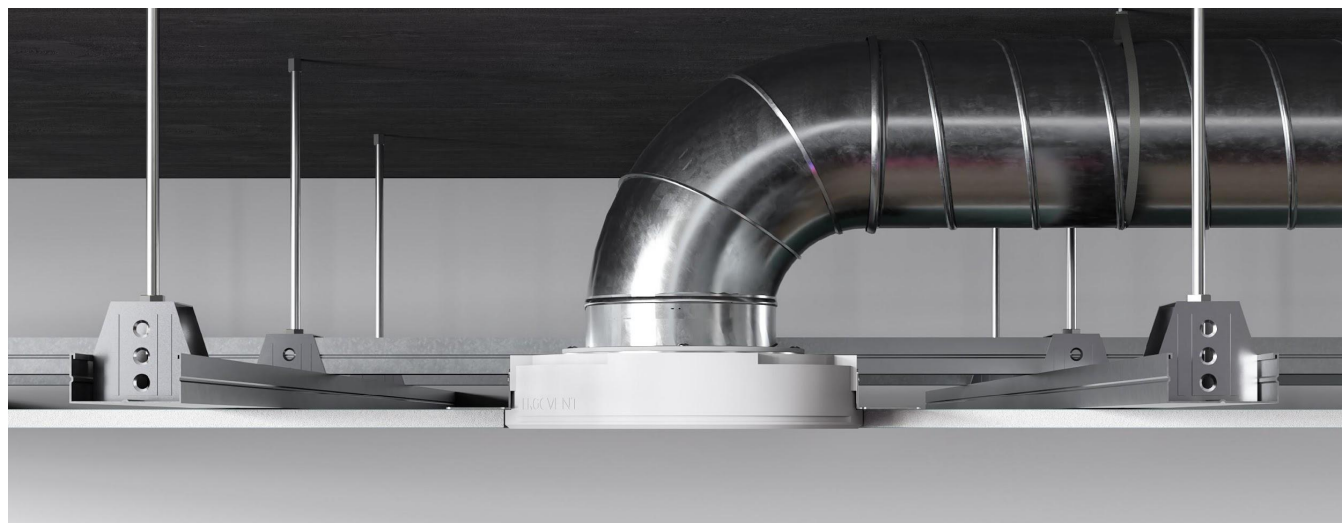
Установка с использованием металлического воздуховода
