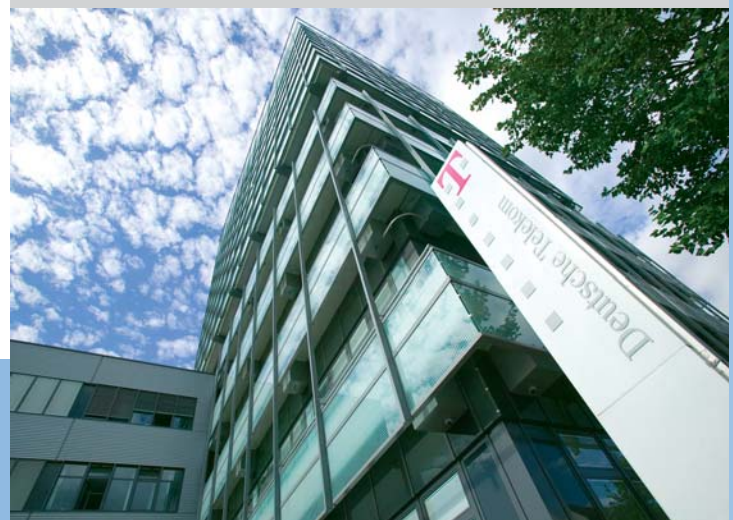
Deutsche Telekom, Frankfurt, Germany
