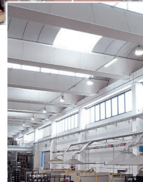
**П**анели лучистого обогрева **Duck Vap** выпускаются в 6-ти различных моделях и в 2-х стандартных цветах, другие цвета по запросу. Каждая модель имеет два варианта длины: 4 и 6 метров (3 и 5 метров – по запросу). Каждая секция легко подсоединяется при помощи сварки труб, которые поставляются со штуцером под приварку.
