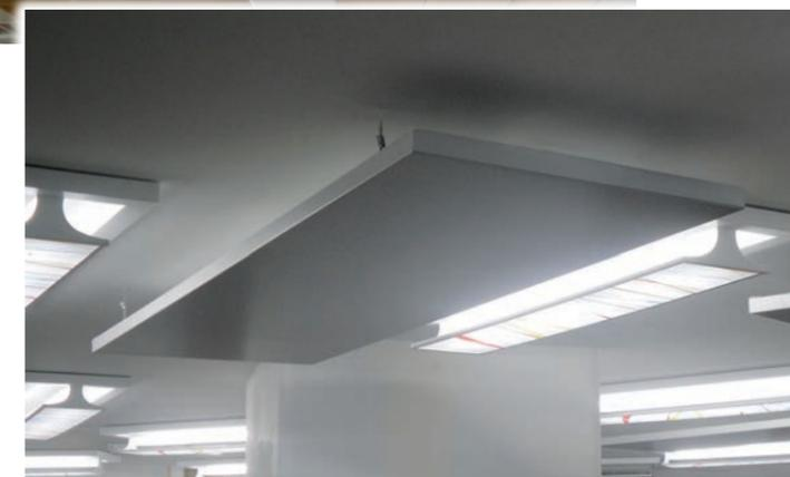
**П**анель может функционировать как на горячей, так и на холодной воде: летом ее следует использовать с основной системой кондиционирования воздуха, поскольку обеспечивается только охлаждение отводом явного тепла.
