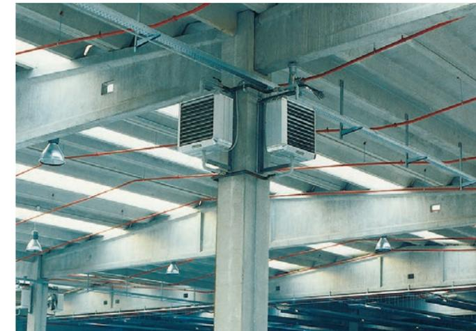
снизить потребление электроэнергии по сравнению с традиционными асинхронными двигателями, непрерывно управлять потоком воздуха и с точностью регулировать температуру окружающей среды. Еще одним преимуществом является низкий уровень шума.
