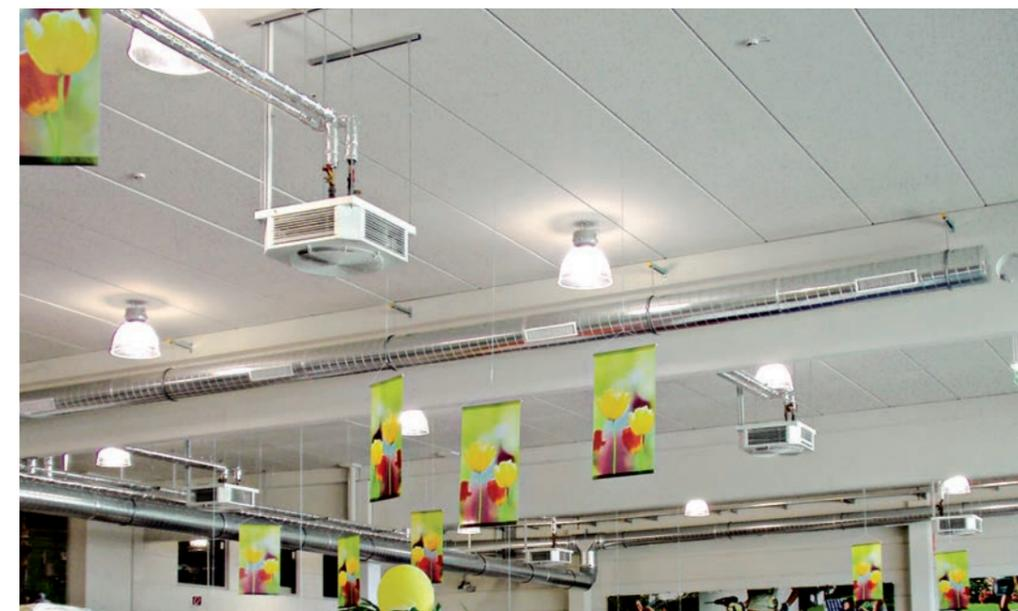
Серия **Elegant ECM** использует инновационный бесщеточный синхронный электродвигатель с постоянным магнитом, который управляется платой инвертера, установленной непосредственно на устройстве.
